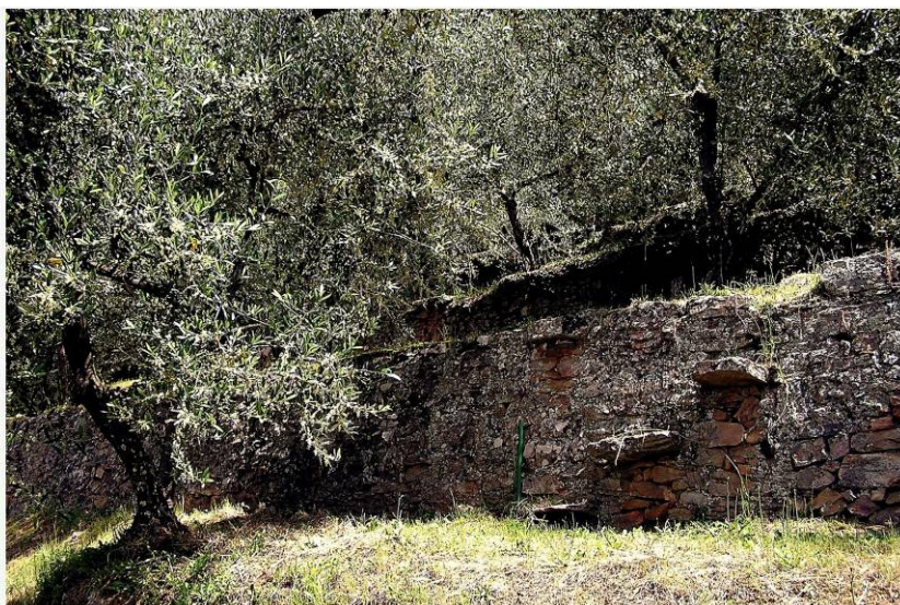
Esempi di scalini inseriti nel muro a secco
